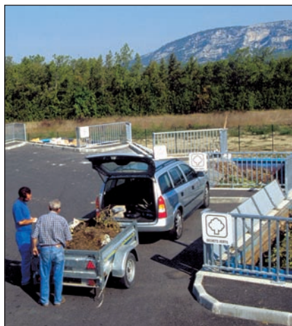
La déchèterie, un équipement qui favorise la gestion des déchets ménagers.
