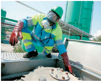
Intervention sur une cuve d'acide.
