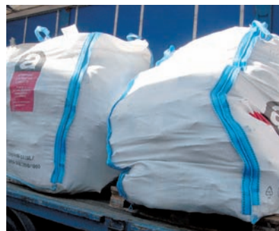
Conditionnement spécifique pour les déchets amiantés.
